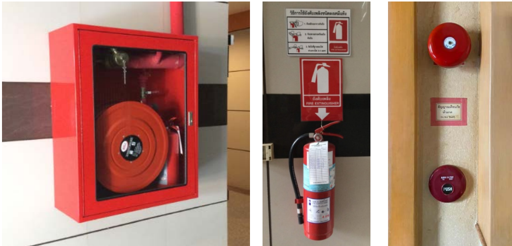
รูปที่ 3.2-11 ตัวอย่างการติดตั้งระบบป้องกันและเตือนอัคคีภัยภายในโครงการ
