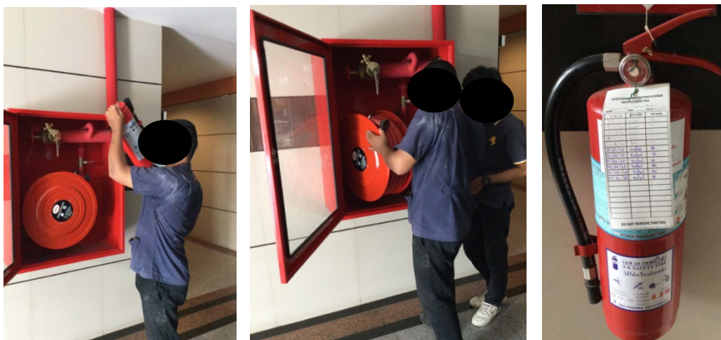
รูปที่ 3.2-13 การตรวจสอบระบบป้องกันและเตือนอัคคีภัย
